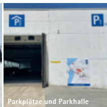
Parkplätze und Parkhalle
